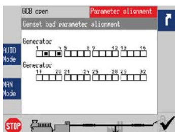
Fig. 146: Genset bad parameter alignment screen
